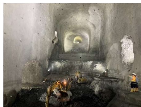
写真-1 地下発電所掘削状況
