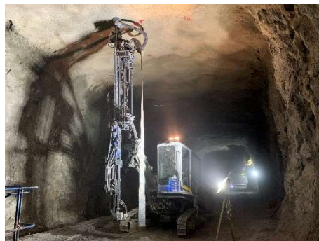
写真-3 上向き削孔状況
