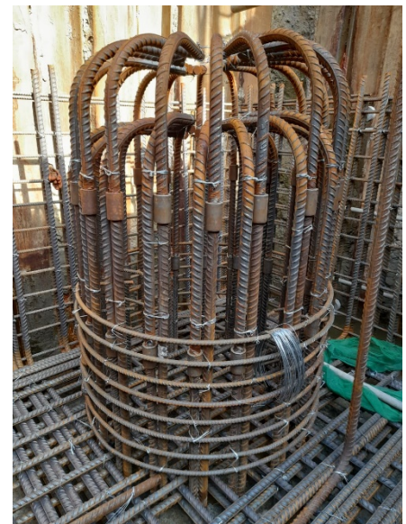
写真-1 杭鉄筋定着部写真
