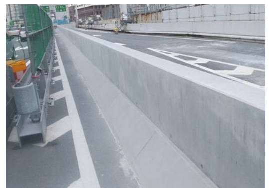
写真1 場所打ち壁高欄施工完了状況
