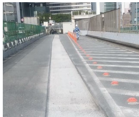
写真2 アスファルト撤去状況
