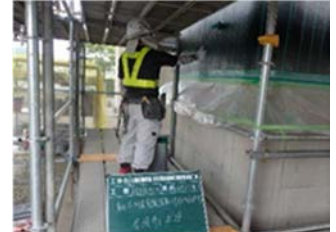
図-4 炭素繊維巻立て工 施工状況 (次世代足場)
