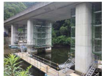
図-6 作業通路組立状況
