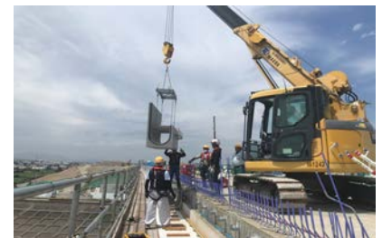
写真-5 吊込み状況
