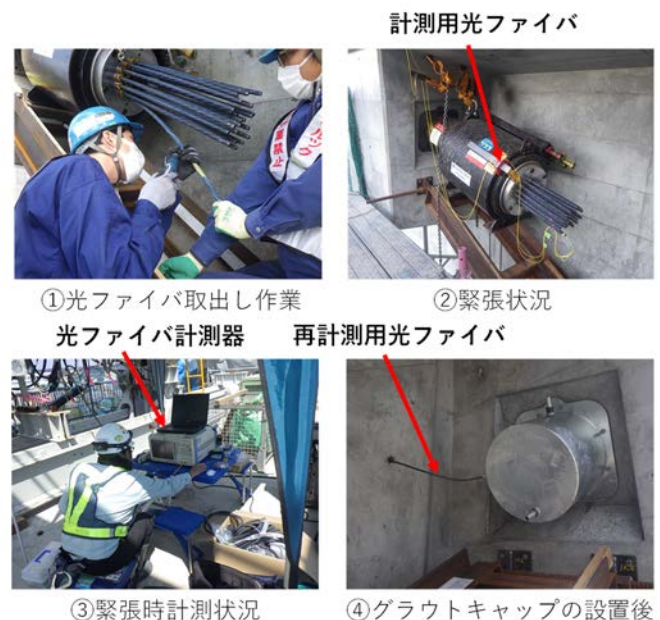
写真-1 光ファイバ計測の作業の状況
