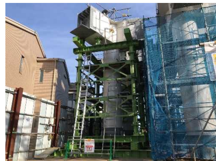
写真-1 1 節柱・仕口地組状況
