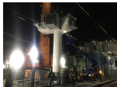
写真-2 地組柱架設状況
