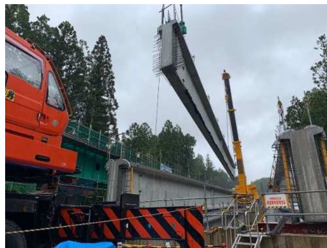
写真-3 主桁架設状況
