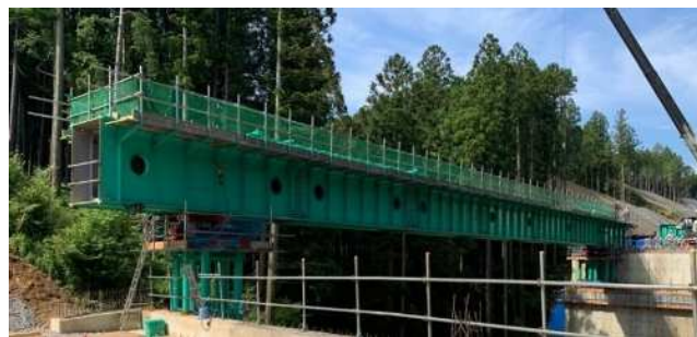
写真-1 架設桁設置状況
