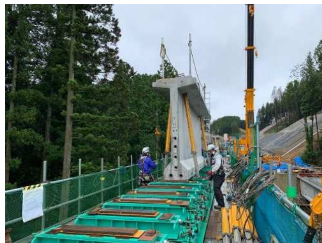
写真-2 主桁組立状況
