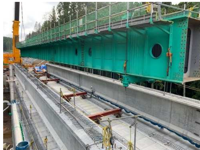
写真-4 架設桁仮置作業状況
