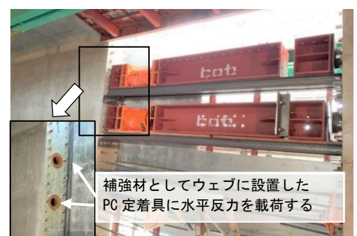
図-7 水平反力調整工
