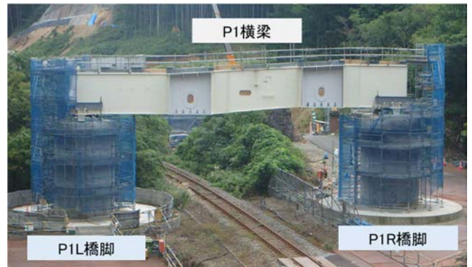
写真-1 P1橋脚部
