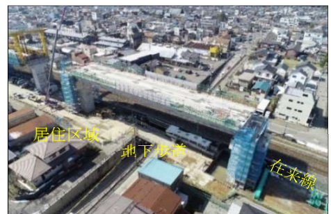
写真-4 PC 箱桁移動後
