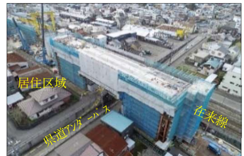
写真-3 PC 箱桁移動前
