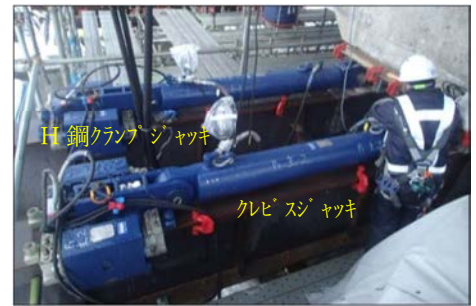
写真-1 横取りジャッキ設置状況
