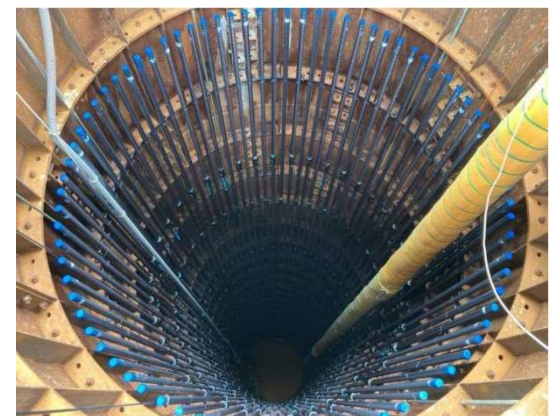
図8 主鉄筋建て込み完了
