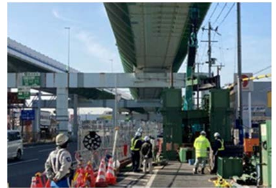
図6 沈設工事状況
