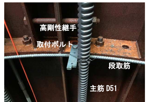
図7 主鉄筋建て込み状況
