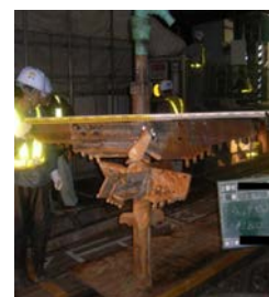
図2 φ1,800mmの掘削ビット
