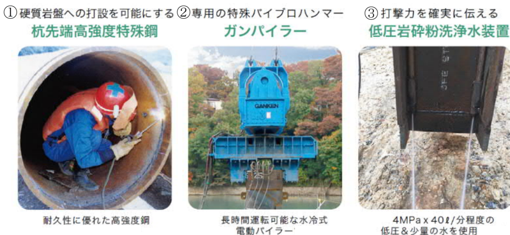
図-1 ガンパイル工法の主要3技術
