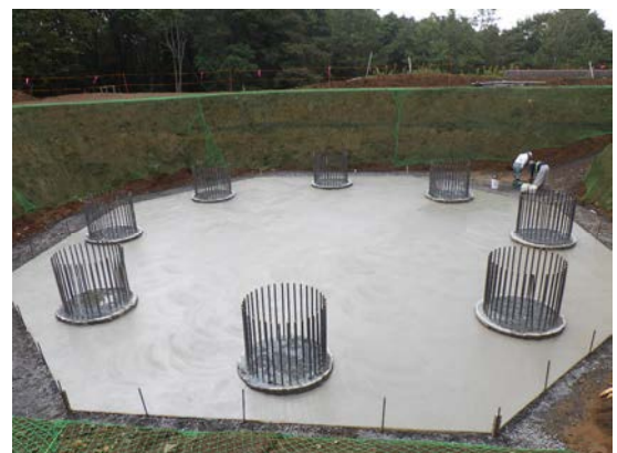
写真2：NT1 杭頭出来形確保
