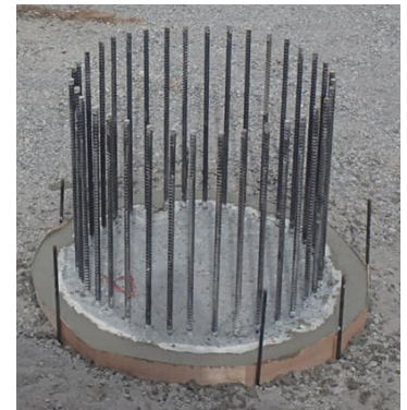
写真1：杭コンクリート増打ち
