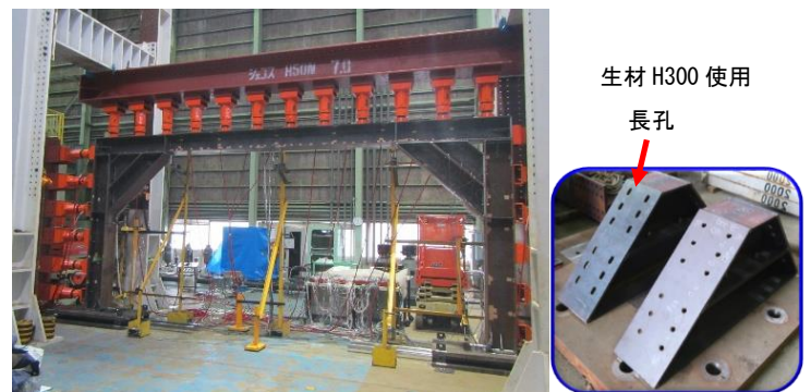
写真-1 試験全景および隅部特殊ピース
