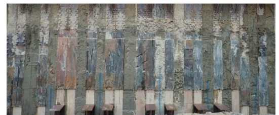
写真-4 連壁仕上がり (H 形鋼および FFU)
