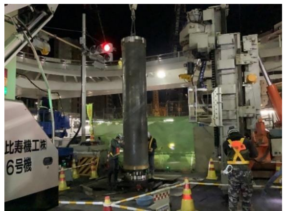
図4 鋼管杭打設状況
