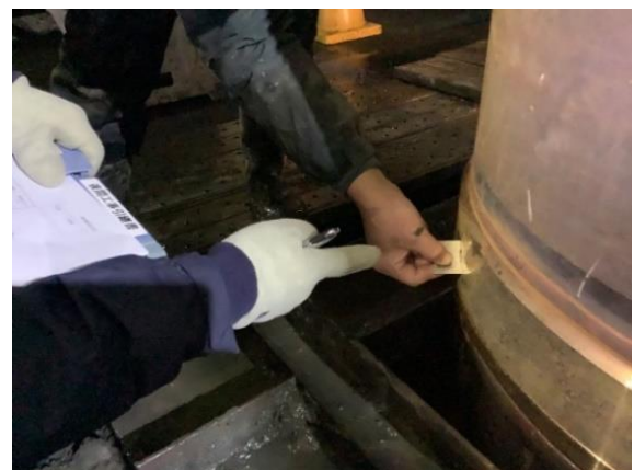
図5 鋼管機械式接手品質管理
