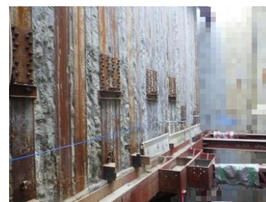
写真-5 土留掘削状況
