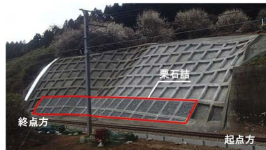
図-4 恒久対策工事
