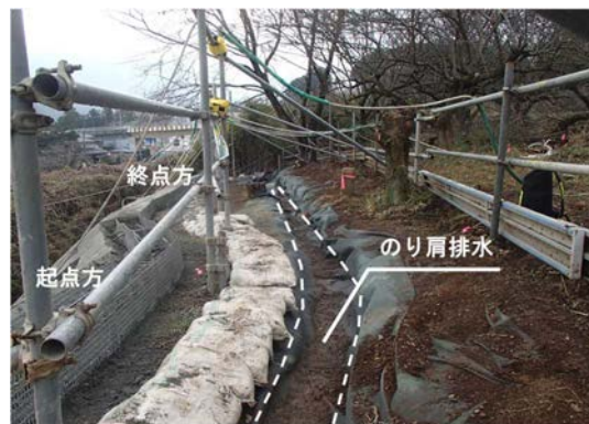
図-2 応急復旧工事(のり肩排水)
