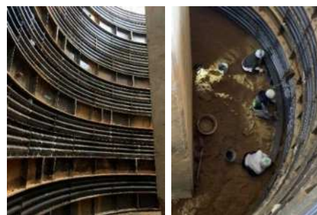
写真-1 現場完成時(左) 現場施工時(右)
