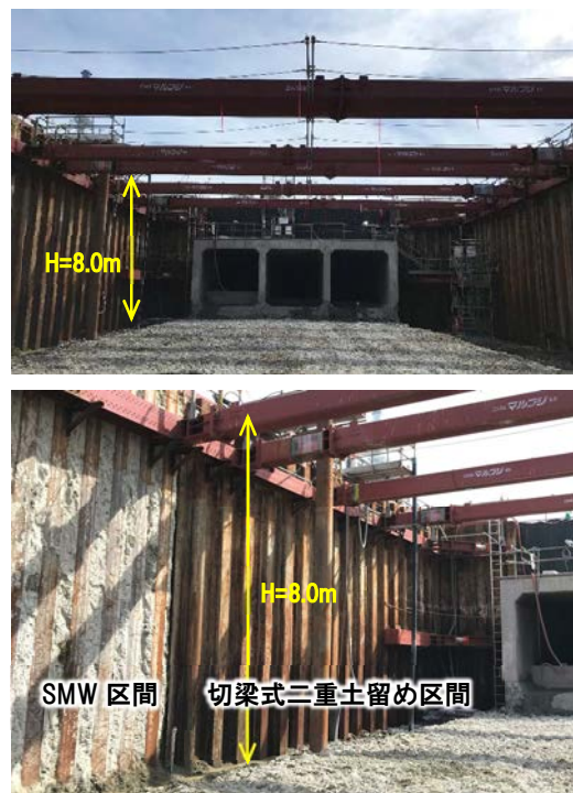
写真-2 掘削・解体完了状況
