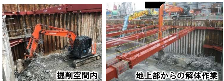
写真-1 既設躯体解体施工状況
