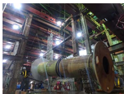
写真-5 鋼管柱の設置状況
