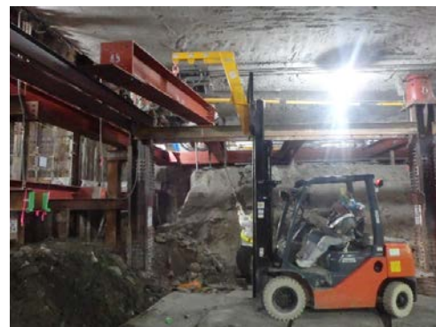
写真-4 市営地下鉄下での土留支保工設置状況
