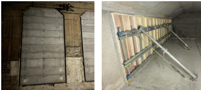
写真-1 埋設型枠使用例 写真-2 木製型枠使用例
