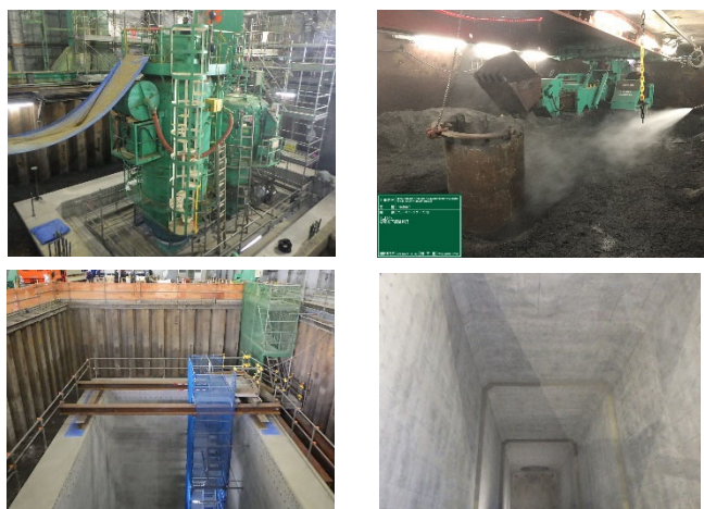
写真1. 施工状況・完成写真
