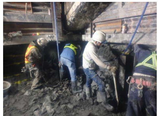
写真-2 ライナー掘削状況
