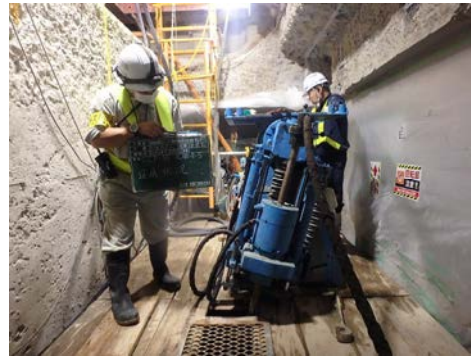
写真-1 地盤改良(CCP-SE)施工状況
