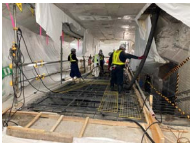
写真-1 間詰めコンクリート打設
