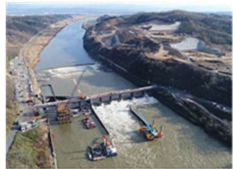
写真-1 新第二床固施工状況
