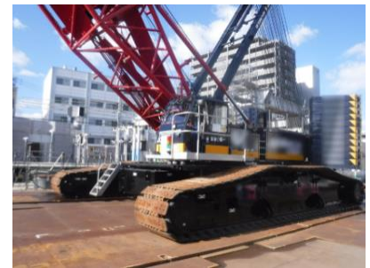
図-2 350t 級クローラクレーン走行時の様子
