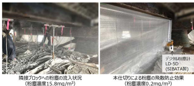
図-4 本仕切りによる粉塵の飛散防止効果
