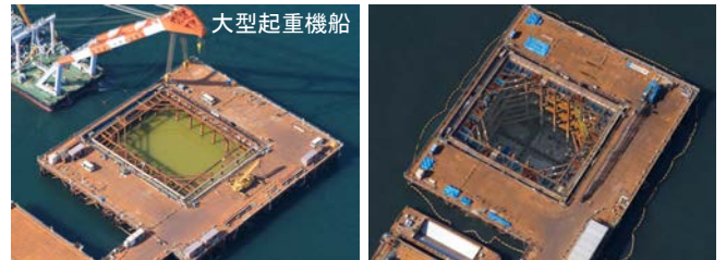
写真-1 大組・水中架設 写真-2 仮締切内排水完了
