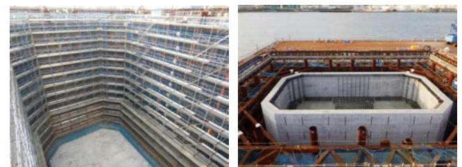
写真-3 足場全段先行設置 写真-4 橋脚躯体完成
