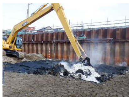
写真-4 泥 Cure の攪拌状況
