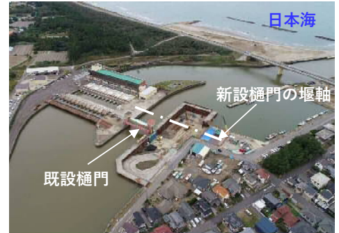
写真-1 施工状況全景
