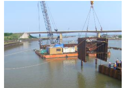
写真-2 ユニット式仮締切の設置状況
