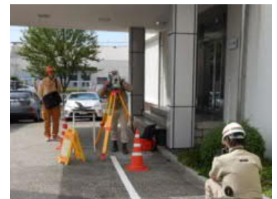
写真-1 調査地点のマーキング状況
