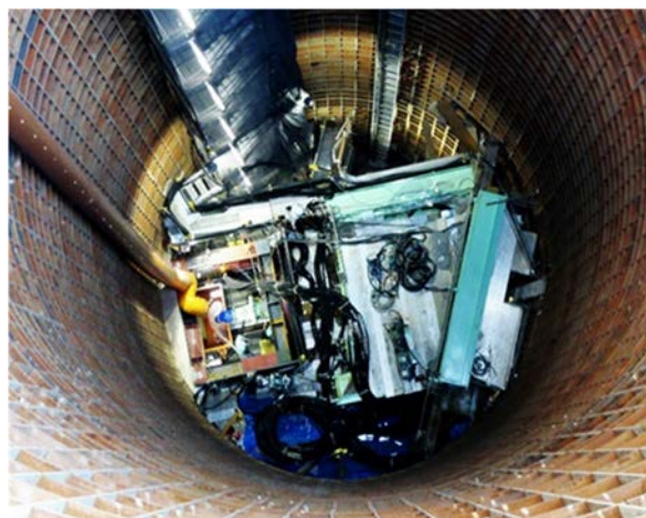
写真-1 初期掘進の状況(立坑上部から撮影)
