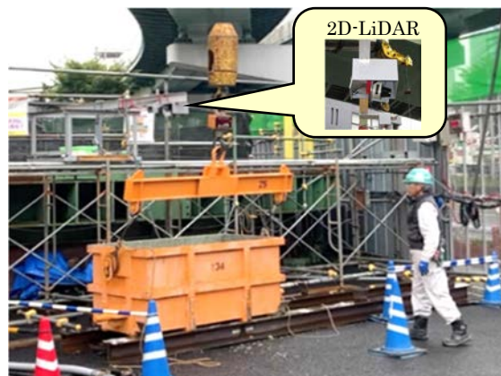
写真-3 土量計測状況
