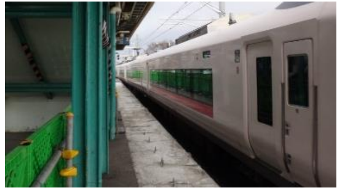
写真-1 施工状況（上りホーム上）
