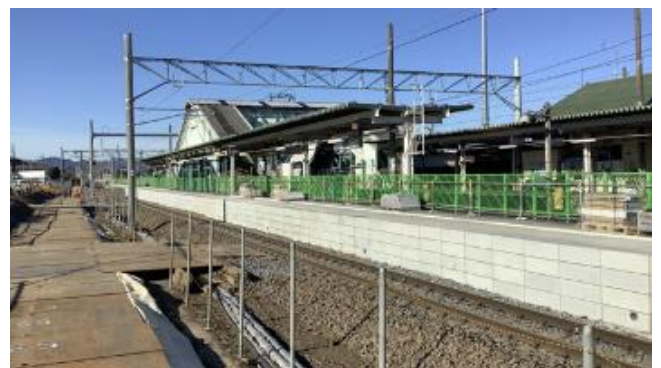
写真-2 施工状況（上本線および上りホーム）
