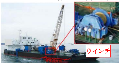
写真1 当初設計に採用されていた多目的作業船
