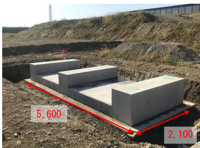
図 1 配管スリーパー基礎形状
