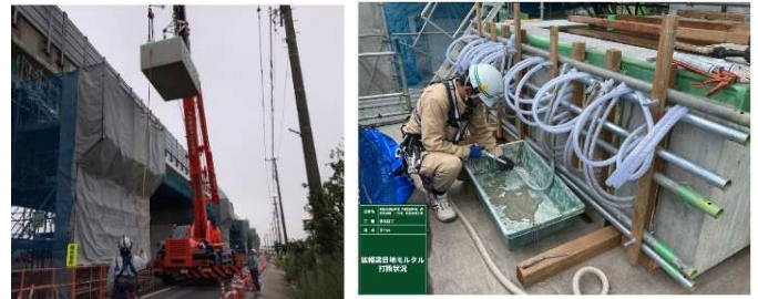
写真-1 プレキャスト拡幅梁架設・目地注入状況
