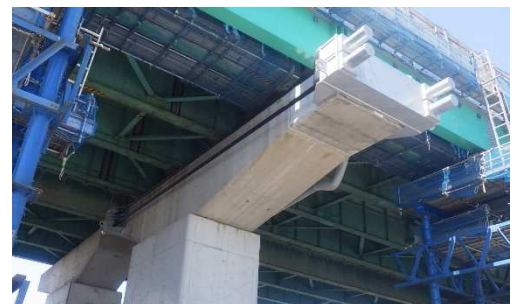
写真-1 下部工拡幅・補強完了
