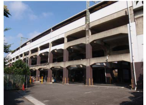
写真-1 駅高架橋(施工前)
