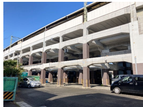
写真-3 駅高架橋 (施工後)
