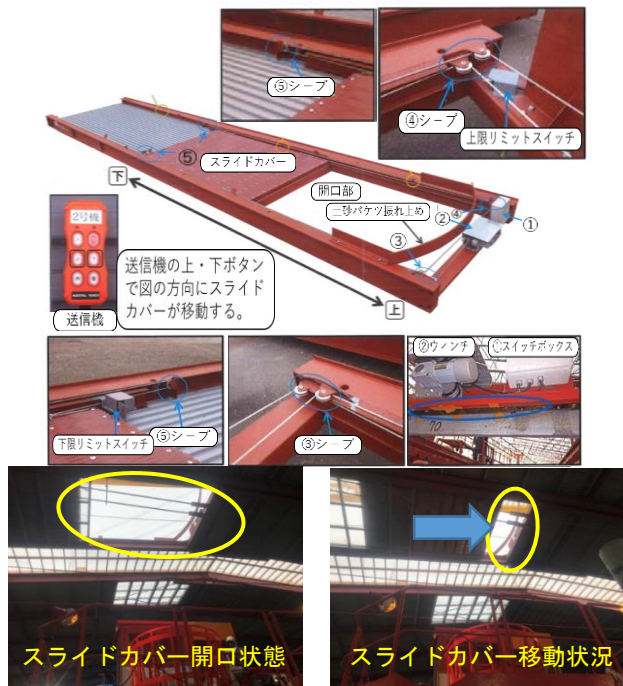
図4 仮設屋根電動開閉式部材詳細
