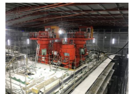
図3 雪寒養生屋根の設置状況
