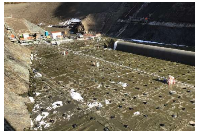
写真2 内ヶ谷ダム堤体養生状況
