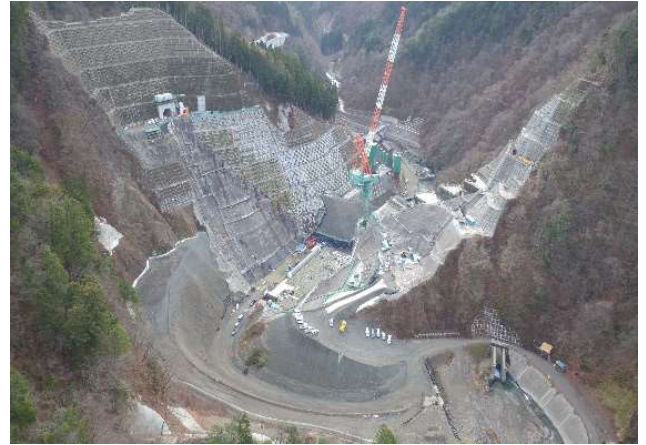
写真1 内ヶ谷ダム堤体上流側全景
