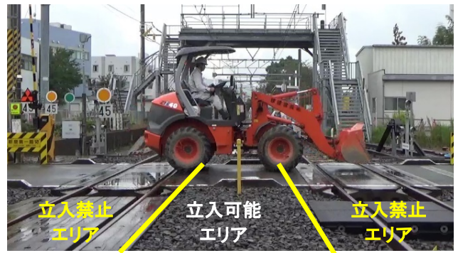
図-3 重機の侵入状況
