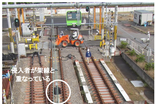
図-5 こ線橋から俯瞰的に見た状況
