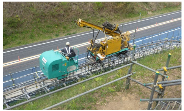
写真-2 大型モノレールによる運搬状況
