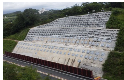
写真-1 施工完了全景
