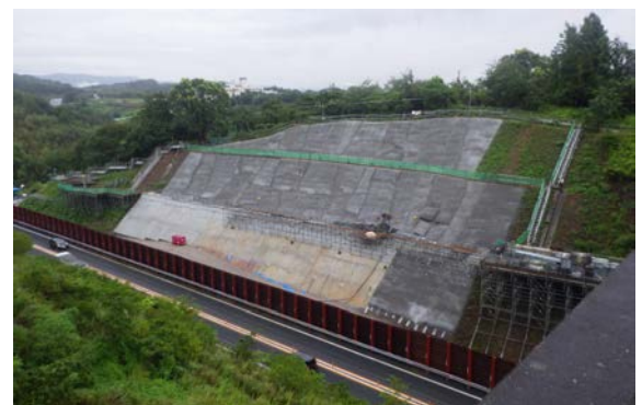
写真-5 再崩落防止策施工状況
