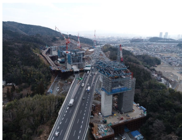
図-8 施工状況全景写真
