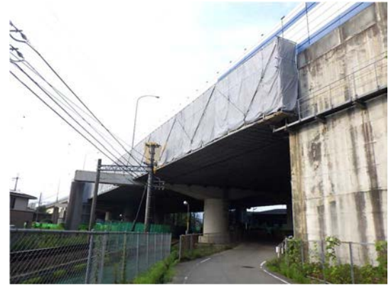
写真-1 施工箇所 全景
