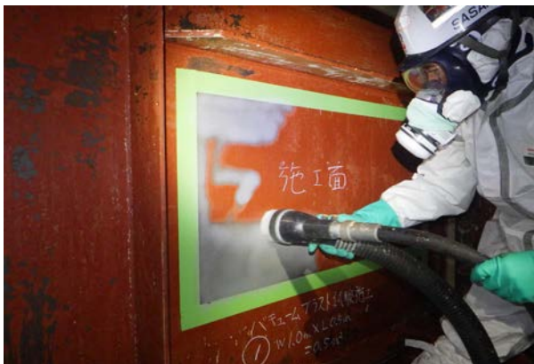
写真-2 施工状況写真
