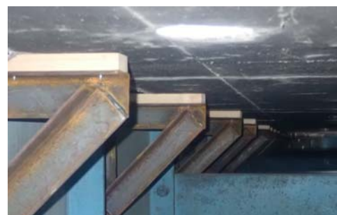
写真-1 床版撤去時仮受ブラケット
