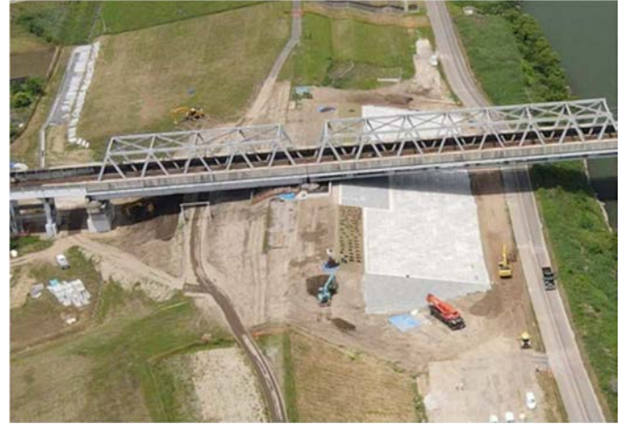
図-1 対象工事施工箇所（施工中）
