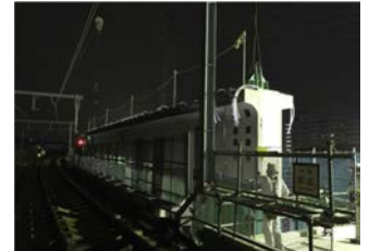
写真-4 PC 桁架設
