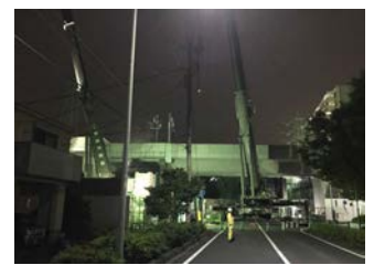
写真-2 クレーン2台配置
