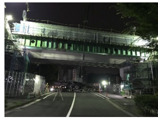
写真-1 PC 桁送出し
