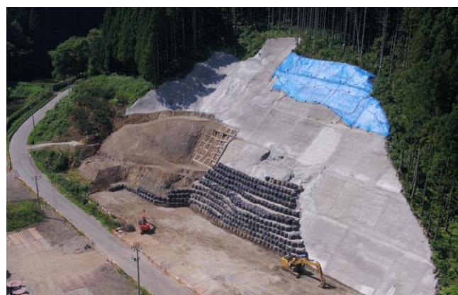
写真—2 仮設大型土嚢設置後の状況
