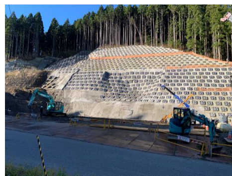
写真-4 施工状況 (施工範囲③の途中)
