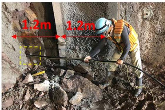
写真-1 装薬状況
